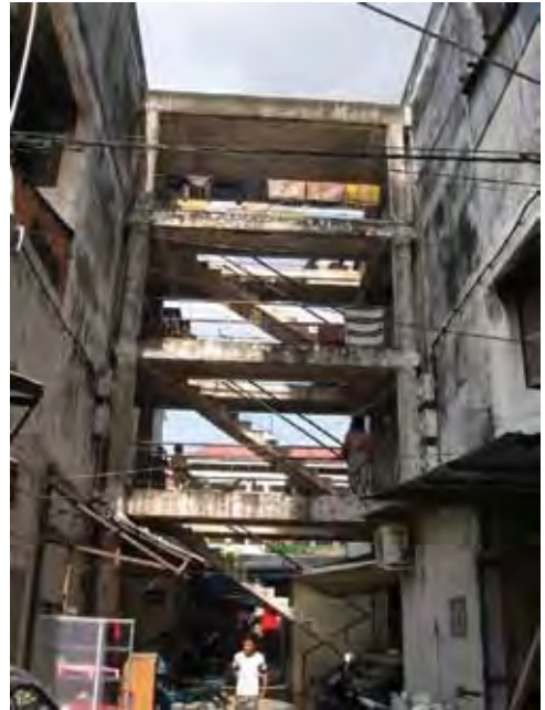
▲ Un escalier du Building
