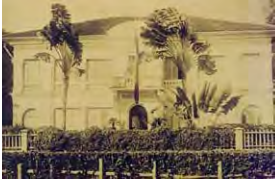
▲ Le bâtiment de la résidence fin 19ème
