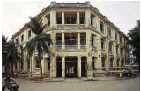
▲ Le commissariat de police après les modifications du début des années 20
