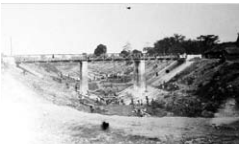
▲ Le pont Ohier en construction. Actuellement un tronçon de la rue 13
